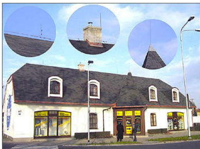
На приведенных фотографиях показан дом, система молниезащиты которого выполнена в виде так называемой молниеприемной сетки. Так как здание имеет несколько усложненную архитектуру, помимо сетки на выступающих элементах конструкции крыши устанавливаются дополнительные штыревые вертикальные молниеприемники, которые должны обеспечить увеличение зоны защиты от прямого удара молнии.
